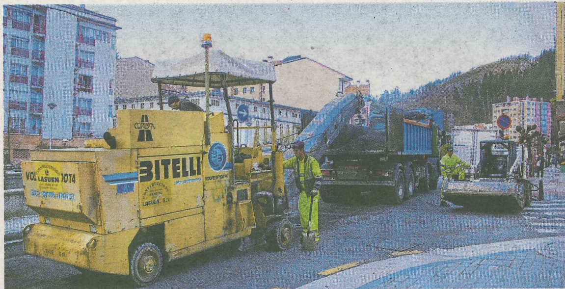
Trabajos de asfaltado que se están llevando a cabo en el barrio de San Pelayo. ■ A. LASUEN
