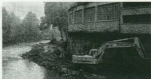
Obras del colector en Carmelo Mendizabal. /ISASTI
