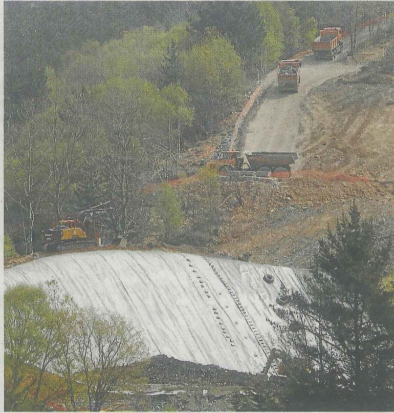
Trabajos de búsqueda de los dos operarios sepultados. Foto: Pablo Viñas
