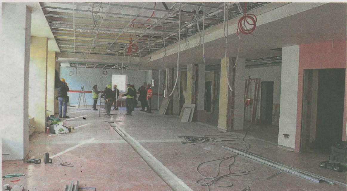
Imagen de las instalaciones, prácticamente diáfanos, durante las obras que ya han concluido. A.L.
