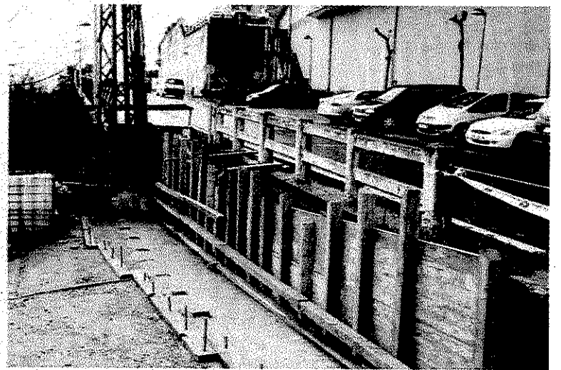
La torreta de Iberdrola será retirada. :: A. GORRITIBEREA
