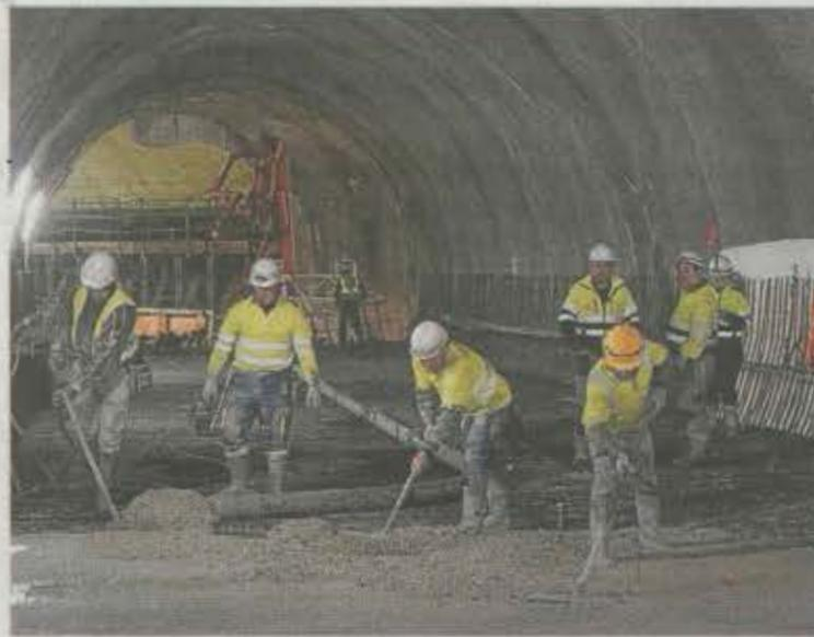
Operarios cubren de hormigón el interior del túnel. LOBO ALTUNA
