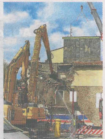
Comienzo del derribo ayer. A.L.
