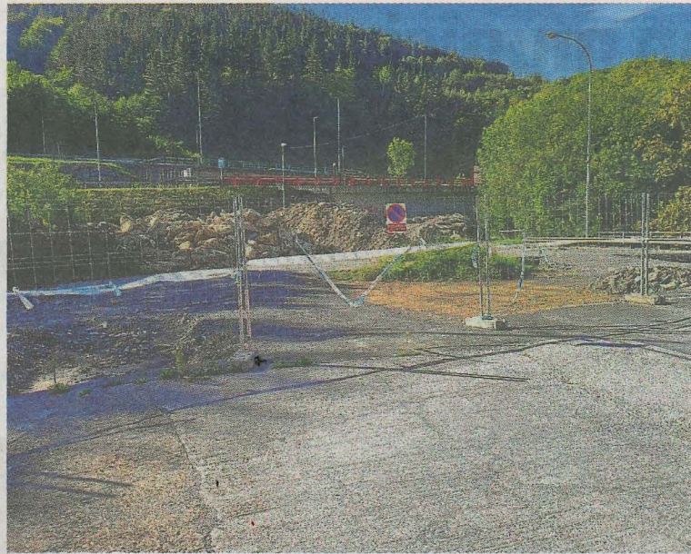
Las obras del colector permanecen paralizadas desde julio. A. LASUEN
