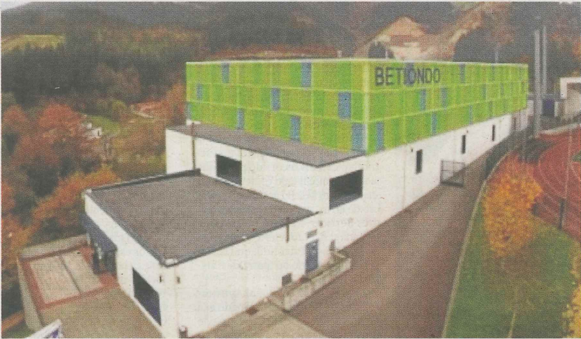
Montaje de cómo quedará la fachada tras los trabajos de reparación.
