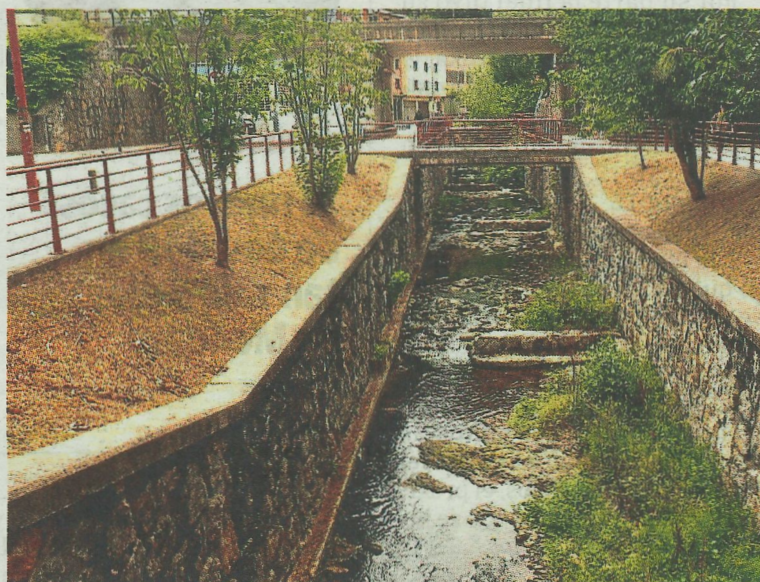
La demolición de 13 azudes permite que el agua fluya sin barreras. AITOR
