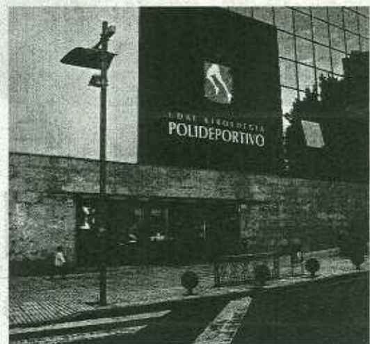
Aspecto del acceso principal del polideportivo. ■ A. L.
