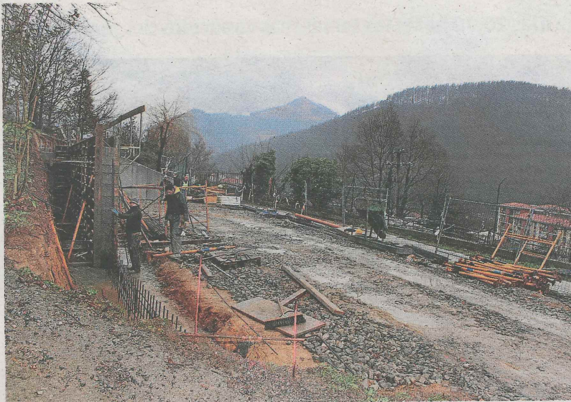
En uno de los laterales de la nueva instalación se está levantando un muro de contención. :: A. LASUEN
