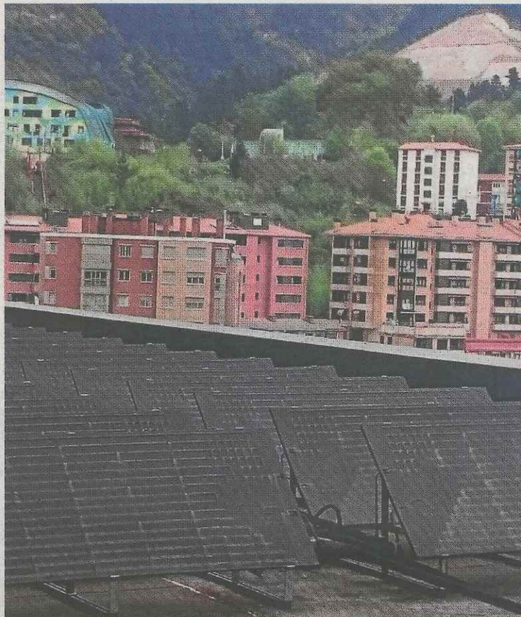
Los paneles solares forman parte de los programas subvencionados.
