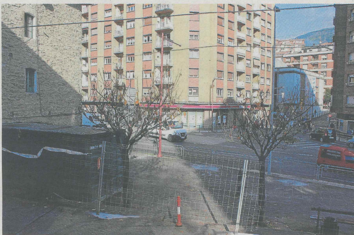
La primera fase de las obras arrancará en esta zona de la plazoleta del cruce de Kaltxango. ■ A. LASUEN
