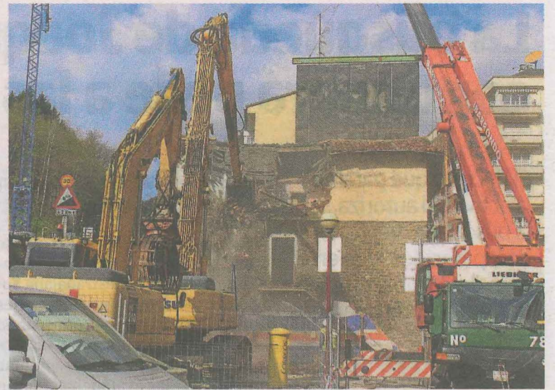
Se instalaron una pantalla y una red de seguridad durante el derribo. A. L.
