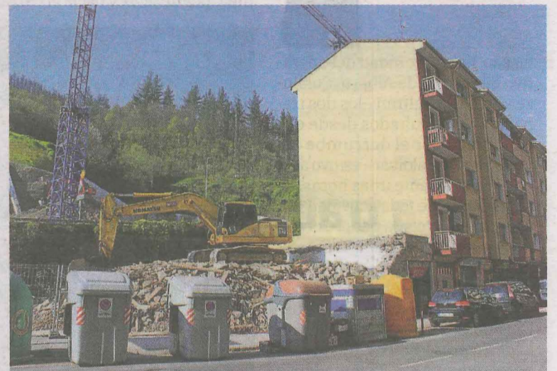
Tras el derribo la zona queda libre para construir viviendas y el paso. A. L.
