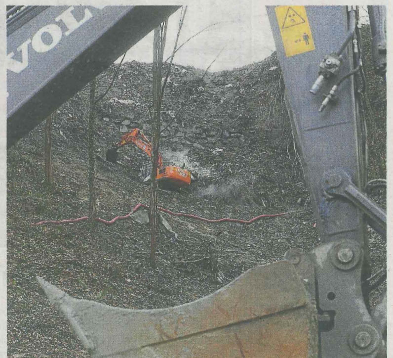
Excavadoras en el vertedero de Zaldibar. Foto: Borja Guerrero
