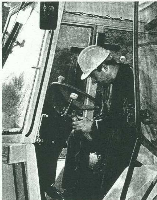
PRÁCTICAS. Un operario maneja una excavadora. /A.L.
