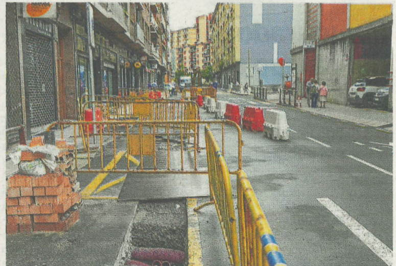
Las obras se han venido realizando desde mayo.
