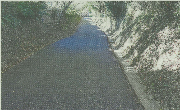
Asfaltado el camino rural de San Roke. A. SALEGI
