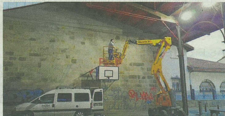
Sustitución de los focos del frontón.
