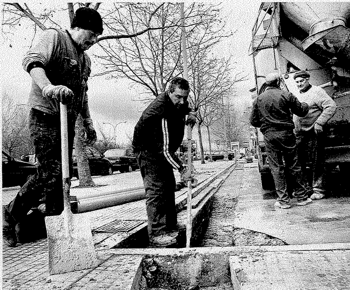
Operarios trabajan en la instalación de fibra óptica en la capital vitoriana. :: EL CORREO
