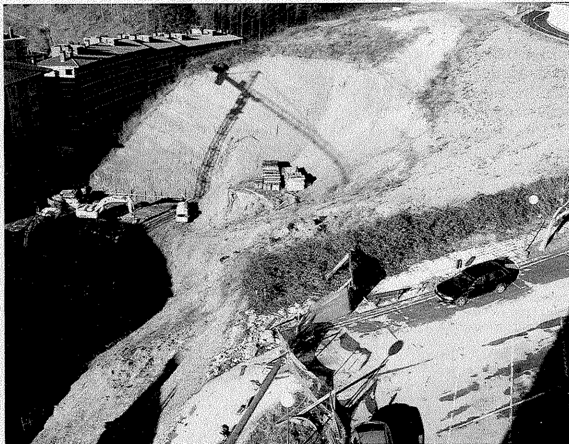
Vista general, desde el barrio Ongarai, de la zona afectada por los desprendimientos. de A. L.
