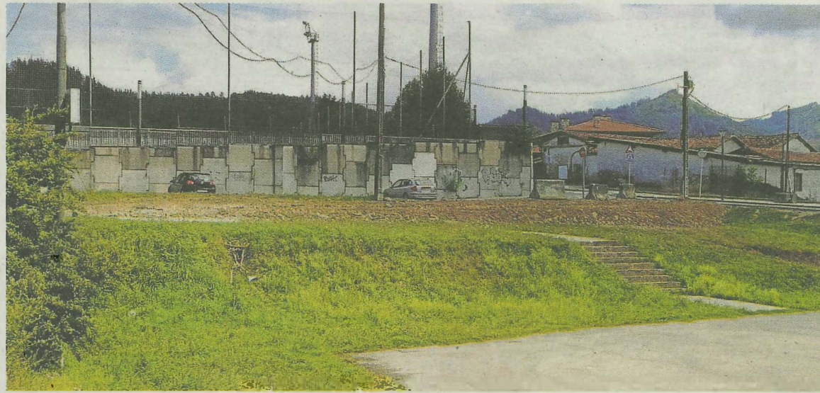
Parte de la zona que servirá para construir la piscina descubierta de Ermua. A. LASUEN
