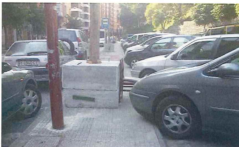
Ilustración 14: Bases de piedra que se colocan en fiestas para enganches de tendidos eléctricos de las barracas.
