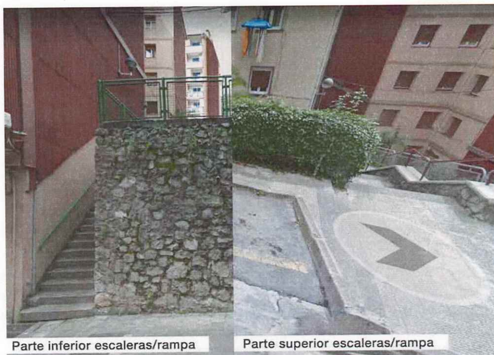
Ilustración 4: Escaleras actuales que conectan las calles de Zubiaurre y Zerukoa y que desaparecerán cuando se ejecuten las obras de la U.E. A-08 Zubiaurre
