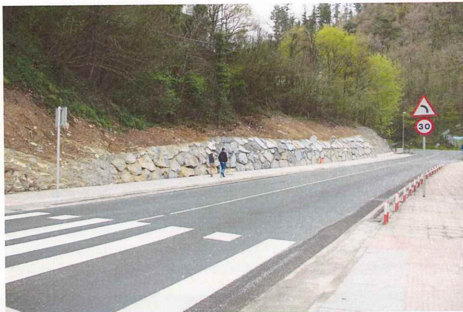
Ilustración 19: Nueva acera y paso de peatones de Okin-Zuri
