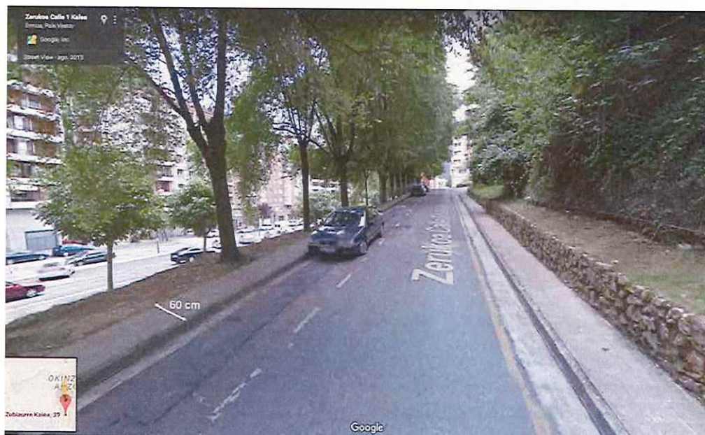
Ilustración 18: Situación actual de las aceras de subida a la calle Zerukoa
