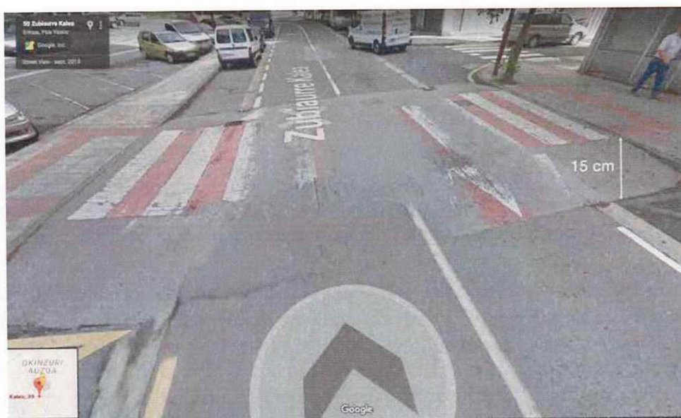
Ilustración 17: Actual de paso de peatones elevado situado en la zona del mercadillo
