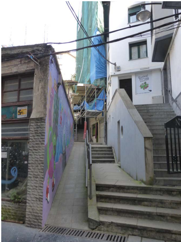
Travesía Erdikokale (rampa y escaleras)
