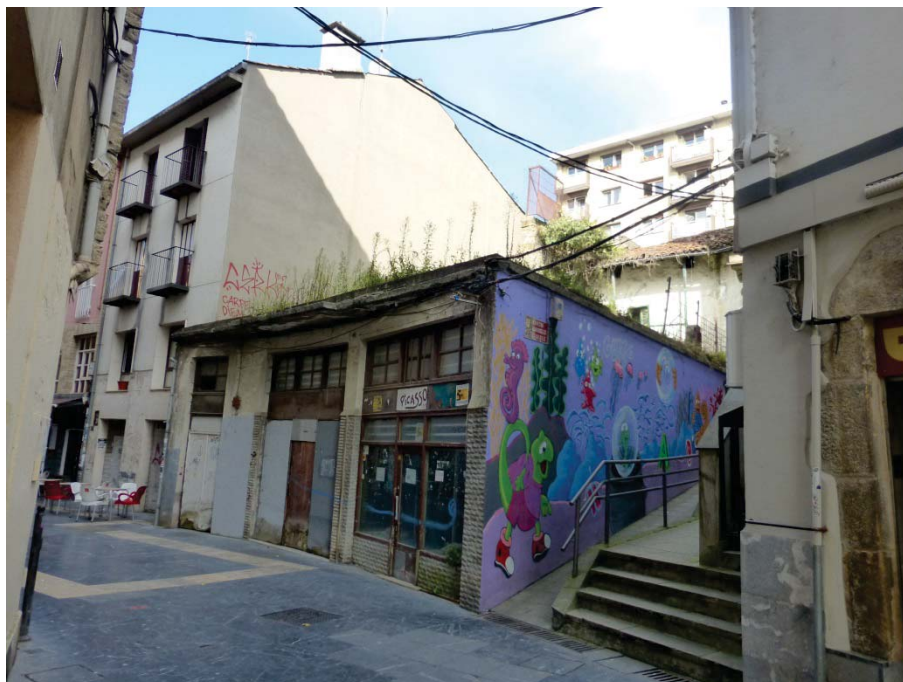
Edificio existente pendiente de derribo c/ Erdikokale nº15ª (antiguo estanco)
