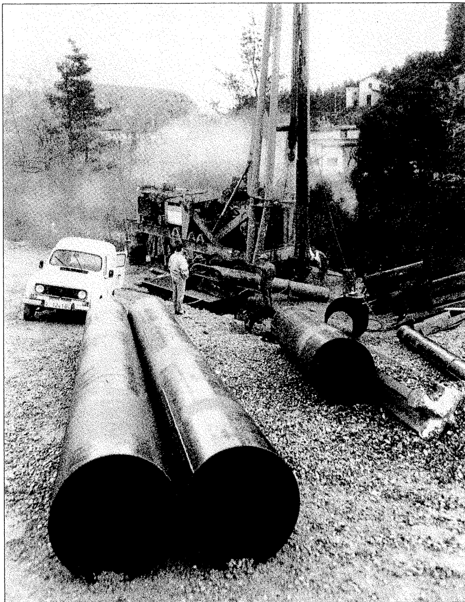
Aspecto de la zona de Mañaria donde se efectúan las obras de sondeos
