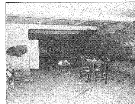
Local en el que se instalará la Escuela-Taller.
